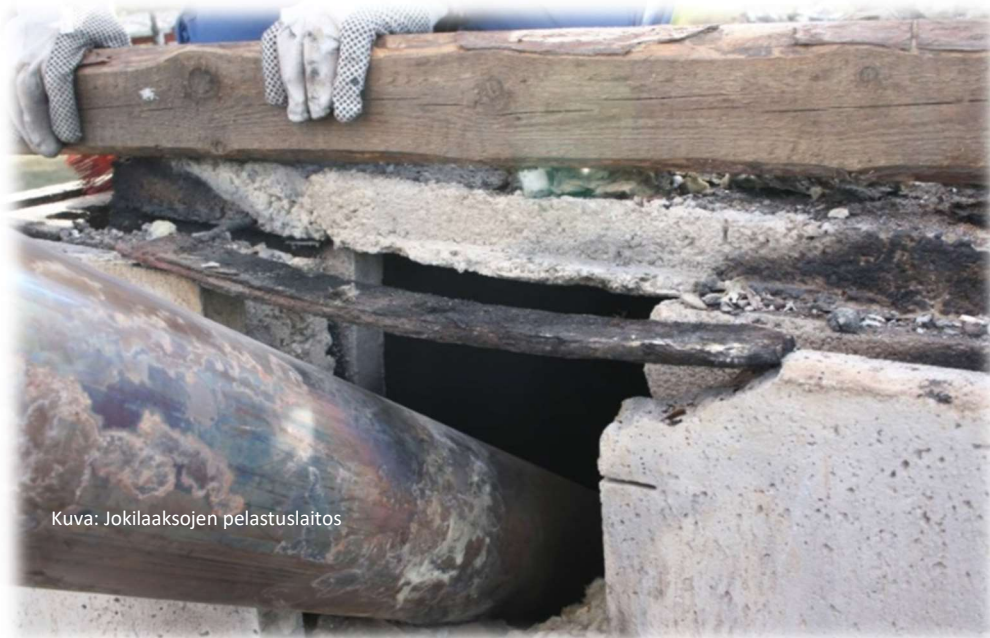
Kuva 9 Puutteellinen suojaetäisyys yhdyshormista palavaan rakennustarvikkeeseen (kohde tuhoutui palossa täysin).
