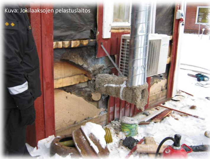
Kuva 6 Puutteellisesti toteutetun metallipiipun seinäläpiviennin aiheuttama palo
